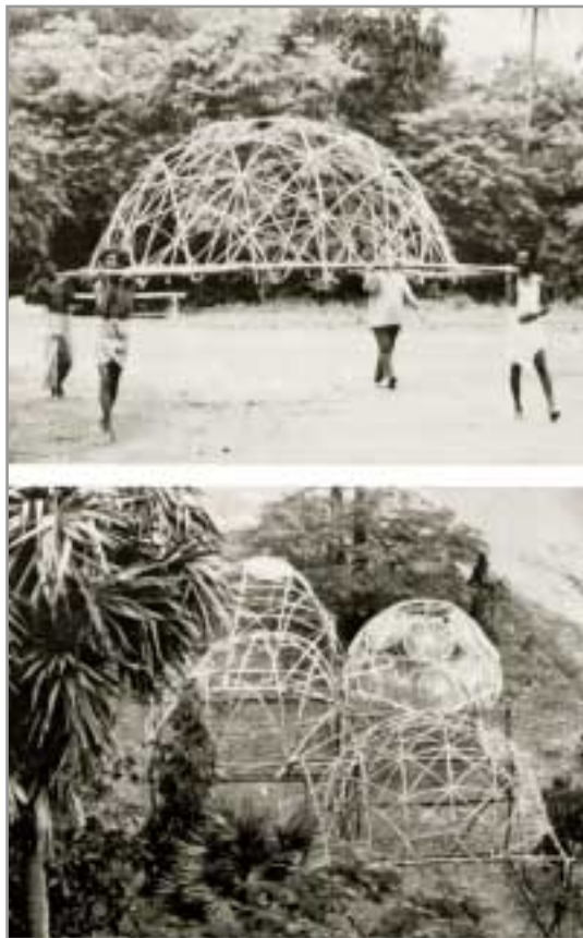
Prototypenbau von Kuppelkonstruktionen mit einheimischen Bambusflechtern am Museum für einfache Technologien an der United Nations University in Madras, Indien und Buckminster Fuller in seinem Atelier mit Strukturmodellen seiner berühmten Domes.
